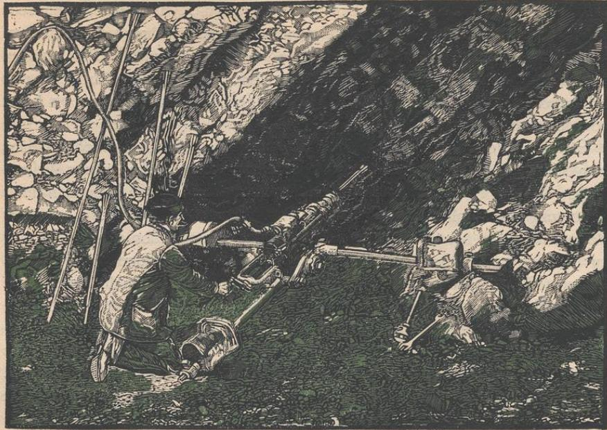
Abb. 89. Bohren eines Sprenglochs in einem Basaltsteinbruch.
