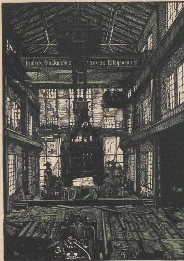
Abb. 76. Elektrischer Laufkran zum Ausbau ganzer Walzgerüste.
