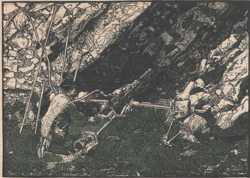
Abb. 89. Bohren eines Sprenglochs in einem Basaltsteinbruch.
