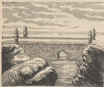
Figur 88. Brücke bei Los Reyes in Mexiko.
