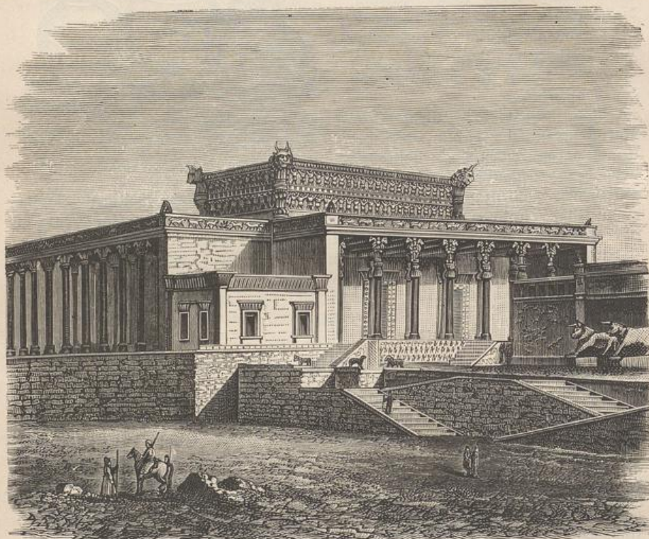
Figur 40. Restaurierte Halle des Xerxes.
