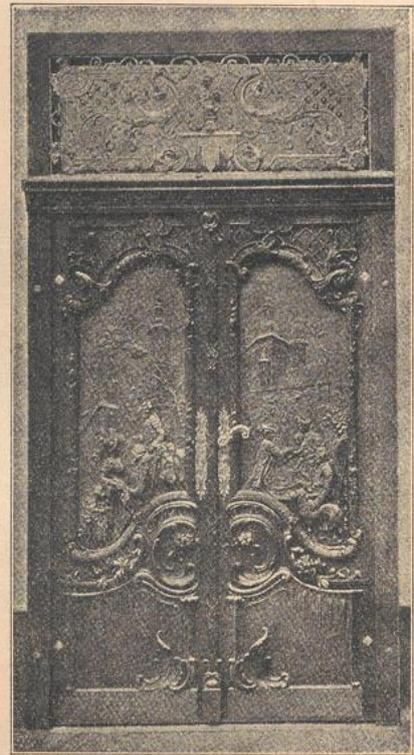
Fig. 445 ist dem unten genannten Werke<sup>126)</sup> entnommen. »Die Figur,« wird dort gefagt, »ist eine reich behandelte, einflügelige Eingangsthür von 1,50 m Lichtweite in einer Rundbogenöffnung mit breitem Futterahmen, Kämpfer und Verdachung. Die auf den Futterahmen, theils zur Ausschmückung, hauptsächlich aber erhöhter Festigkeit wegen aufgelegten, strebepfeilerartigen Pfosten sind im Querschnitt angedeutet, eben so wie die Seitenansicht eines Theiles der Thür. Sehr leicht lässt sich diese
