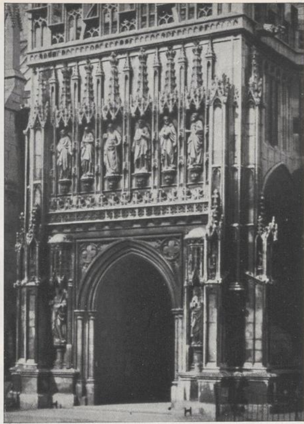
ENGLAND. Gloucester, Kathedrale, Südportal
