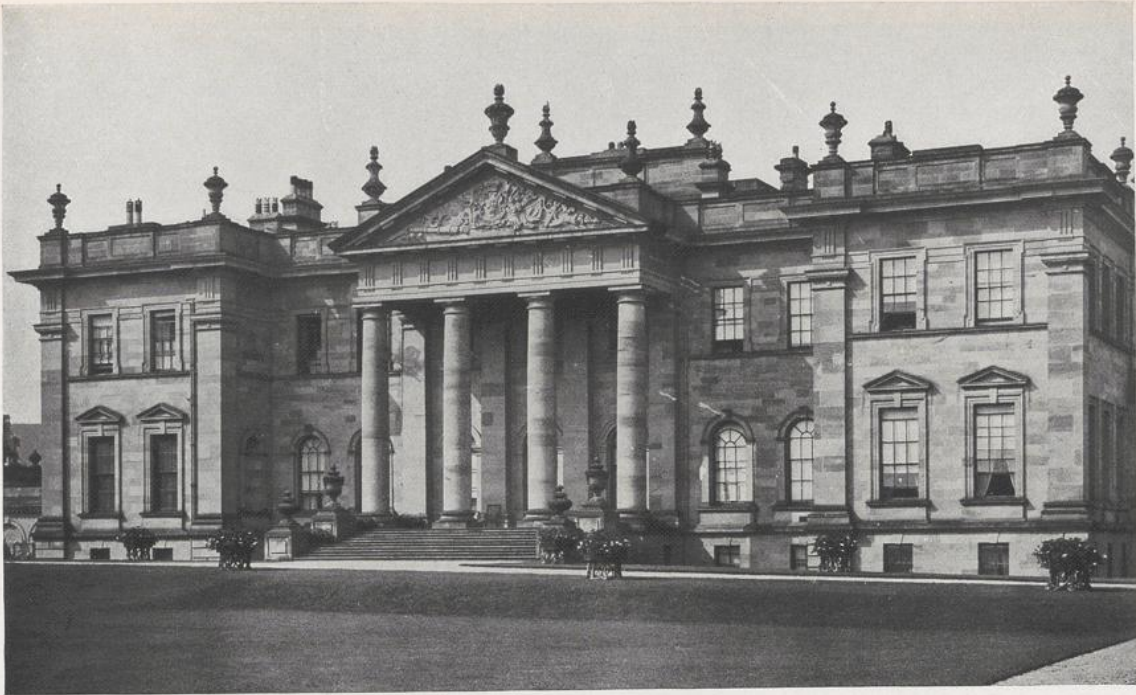
ENGLAND. Schloß Duncombe Park. Vanbrugh
