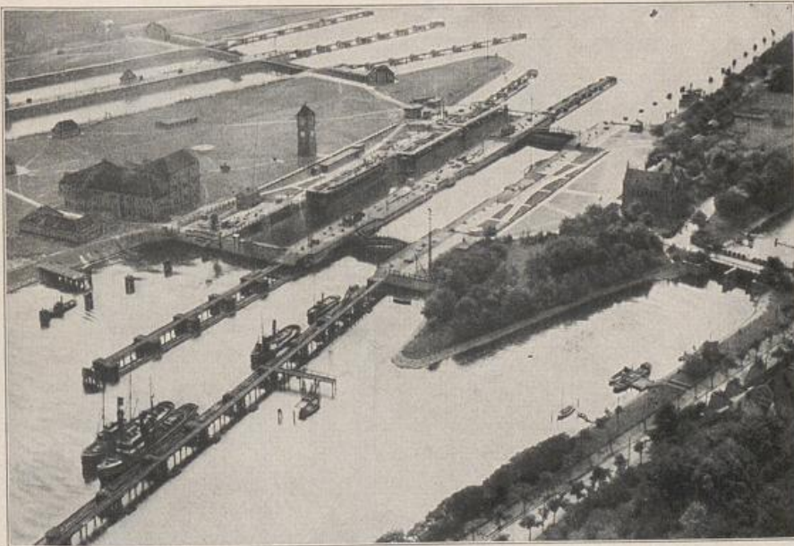
115. Die Holtenauer Schleuse. Das Ende des Nordostseekanals (Kaiser-Wilhelm-Kanals) bei Holtenau an der Kieler Förde ist (wie jenes bei Brunsbüttel an der Elbe) durch Schleusen geschützt. Diese sind hier aber nicht wegen der ganz unbedeutenden Gezeiten nötig, sondern wegen der Wasserstandschwankungen, die durch Winde in der Förde verursacht werden. Im Vordergrund sieht man die alte Schleuse, die heute als Trockendock verwendet wird, im Hintergrund die neuen Schleusen, die mit 330 m Länge, 45 m Breite und 14 m Tiefe die größten der Welt sind.
