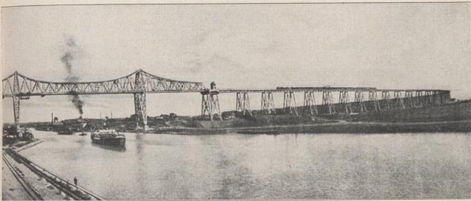
Kanal) bei Rendsburg. An die 42 m hohe Brücke über den Kanal schließen sich beiderseitig verlängerung in Schleifenform ist in dem flachen Gelände nötig wegen der Höhendifferenz von 27 m bis nötig, damit auch Schiffen mit außergewöhnlich hoher Takelung der Durchgang möglich ist.
