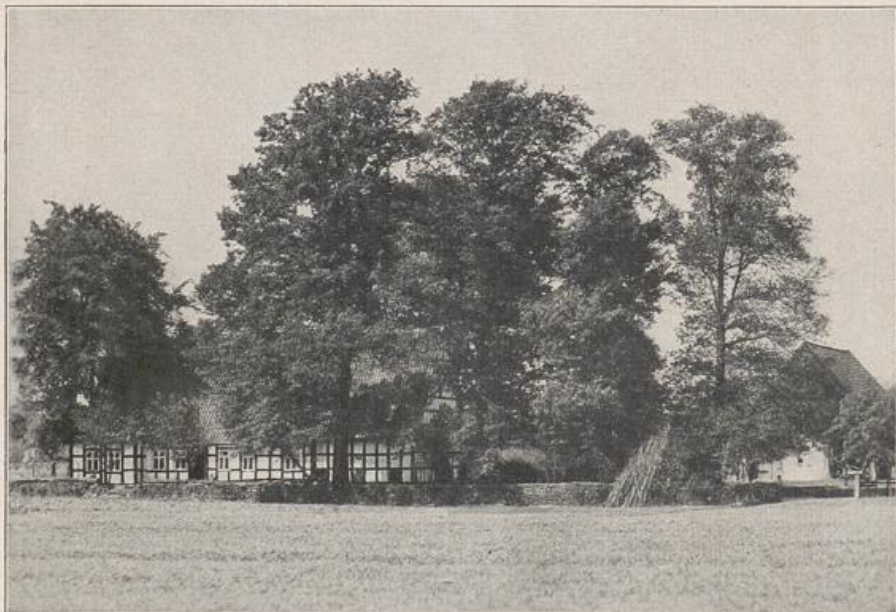
84. Niedersächsisches Bauerngehöft. Der niedersächsische Bauer umgibt in Dorf- wie in Einzelsiedlung sein Haus mit einem Kranz von Eichen, die ihm Windschutz und Schatten spenden. Die Abgrenzung des Eigengutes gegen Nachbarn und Straße geschieht durch Zaun oder Hecke, neuerdings gern durch eine Backsteinmauer. Das Haus war früher in Lehmfachwerk, dann in Backsteinfachwerk hergestellt, jetzt aber gewinnt der massive Backsteinbau an Boden. Zur bequemeren Deckung des Viehes entstand der Typ des Langhauses für Mensch, Vieh und Ernte. Der Scheunerraum, die Tenne, zu beiden Längsseiten von den Krippen der Viehställe flankiert, reicht vom Einfahrtstor bis zu den Wohnräumen an der anderen Schmalseite des Hauses.
