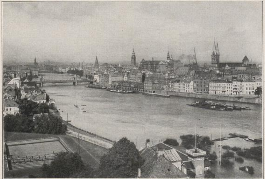
81. Der Bremer Freihafen. Der Aufschwung der alten Hansestadt erfolgte mit der Eröffnung des Freihafens 1888 und der Unterweserkorrektur, die mittelgroßen Schiffen den Weg nach Bremen selbst gestattet. Das 6,8 m tiefe Hauptbecken der Bremer Anlagen ist 2 km lang und 120 m breit. Großartige Speicher, Lösch- und Ladeeinrichtungen ziehen sich an den Kais entlang.
