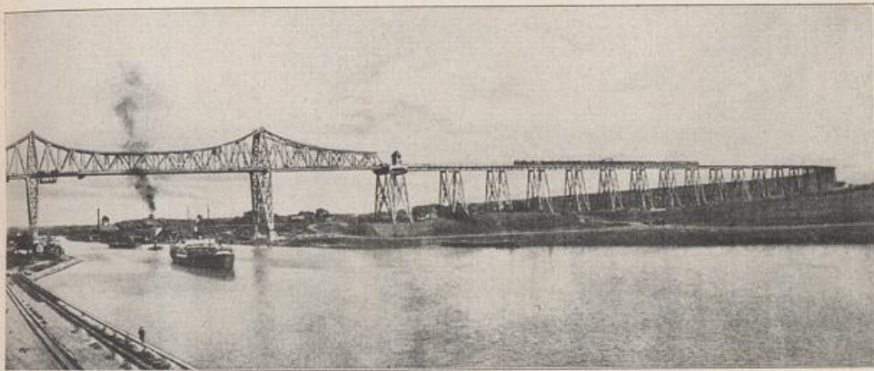
Kanal) bei Rendsburg. An die 42 m hohe Brücke über den Kanal schließen sich beiderseitig verlängerung in Schleifenform ist in dem flachen Gelände nötig wegen der Höhendifferenz von 27 m bis nötig, damit auch Schiffen mit außergewöhnlich hoher Takelung der Durchgang möglich ist.
