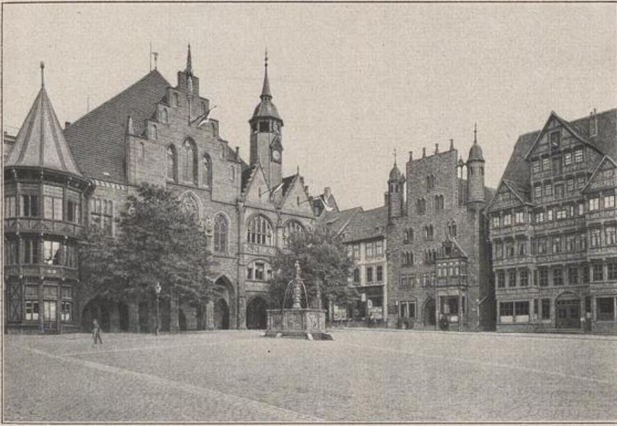
225. Der Altstädter Markt zu Hildesheim. Der Kern des gotischen Rathauses ist um die Mitte des 15. Jahrhunderts entstanden. Das »Tempelherrenhaus« rechts war ein Patrizierhaus aus derselben Zeit. Das Wedekindsche Haus, weiter rechts, ist ein Fachwerkbau, bis in die Giebel hinauf mit Schnitzwerk reich verziert.
