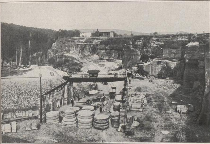
248. Steinbruch bei Lohmen a. d. Wesenitz (rechter Nebenfluß der Elbe). Der Quadersandstein wird an vielen Stellen des Elbtals innerhalb der Sächsischen Schweiz gebrochen, zu Platten, Mühlsteinen und Säulen behauen, auf Rutschbahnen oder Seilwagen zum Elbufer gebracht und dort verladen.
