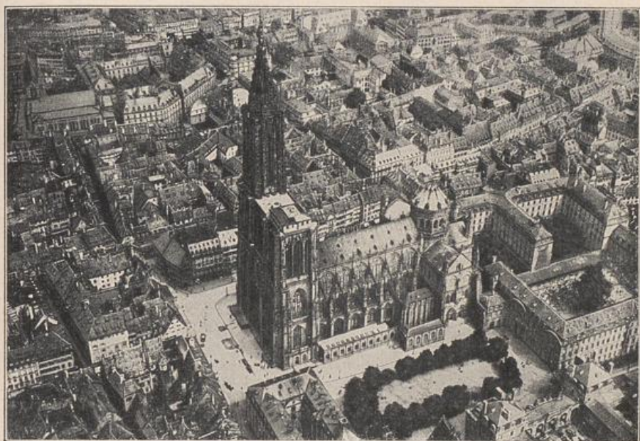
278. Fliegeraufnahme vom Straßburger Münster. Da, wo die alte Straße von Paris nach der Donau den Rheinstrom überschritt, erwuchs die Stadt Straßburg. Im Mittelalter gelangte sie zu hoher Blüte. Damals wurde das prächtige Münster, eines der hervorragendsten Denkmäler deutscher Baukunst, errichtet. Sein 142 m hoher Turm ist das Wahrzeichen der »wunderschönen Stadt«, die seit 1871, nachdem sie wieder deutsch geworden war, einen großen Aufschwung genommen hatte.
