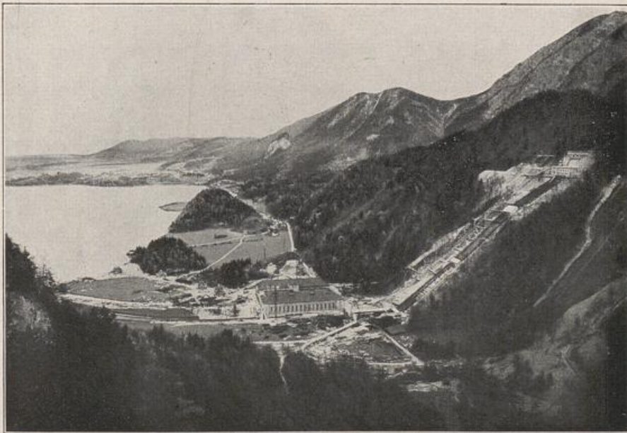
329. Walchenseewerk. Das Bild zeigt links ein Stück des Kochelsees am Fuß der bayerischen Alpen. Nur 2 km in der Luftlinie entfernt, aber 200 m höher und durch eine Wasserscheide getrennt, liegt (rechts außerhalb des Bildes) der stattliche Walchensee. Er ist durch eine Rohrbahn (rechts im Bilde) angezapft. Die so gewonnenen ungeheuren Wasserkräfte werden in dem Krafthaus (unter der Mitte des Bildes) in elektrische Kraft verwandelt, die einen großen Teil der oberbayerischen Bahnen zu speisen bestimmt ist. Das bayerische Stromnetz ist neuerdings mit dem mitteldeutschen verbunden.
