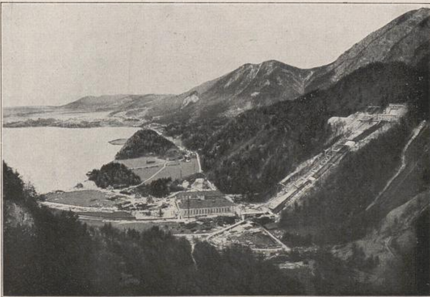
329. Walchenseewerk. Das Bild zeigt links ein Stück des Kochelsees am Fuß der bayerischen Alpen. Nur 2 km in der Luftlinie entfernt, aber 200 m höher und durch eine Wasserscheide getrennt, liegt (rechts außerhalb des Bildes) der stattliche Walchensee. Er ist durch eine Rohrbahn (rechts im Bilde) angezapft. Die so gewonnenen ungeheuren Wasserkräfte werden in dem Krafthaus (unter der Mitte des Bildes) in elektrische Kraft verwandelt, die einen großen Teil der oberbayerischen Bahnen zu speisen bestimmt ist. Das bayerische Stromnetz ist neuerdings mit dem mitteleuropäischen verbunden.
