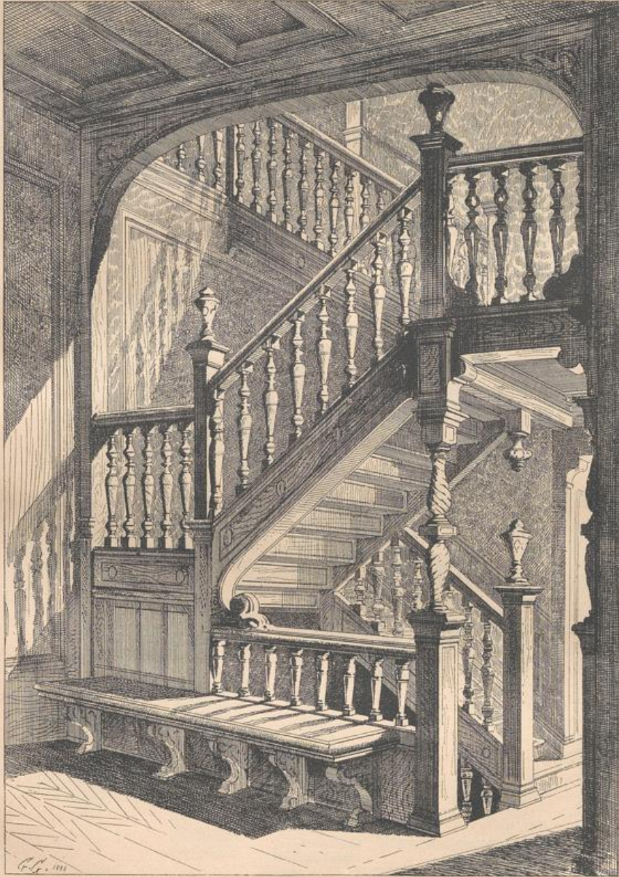
Treppe im Altersverforgungshaus zu Villemonble 14) .
