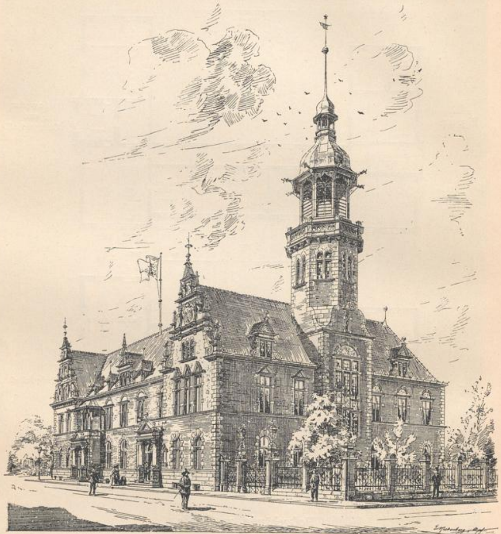
Postgebäude zu Neisse.
