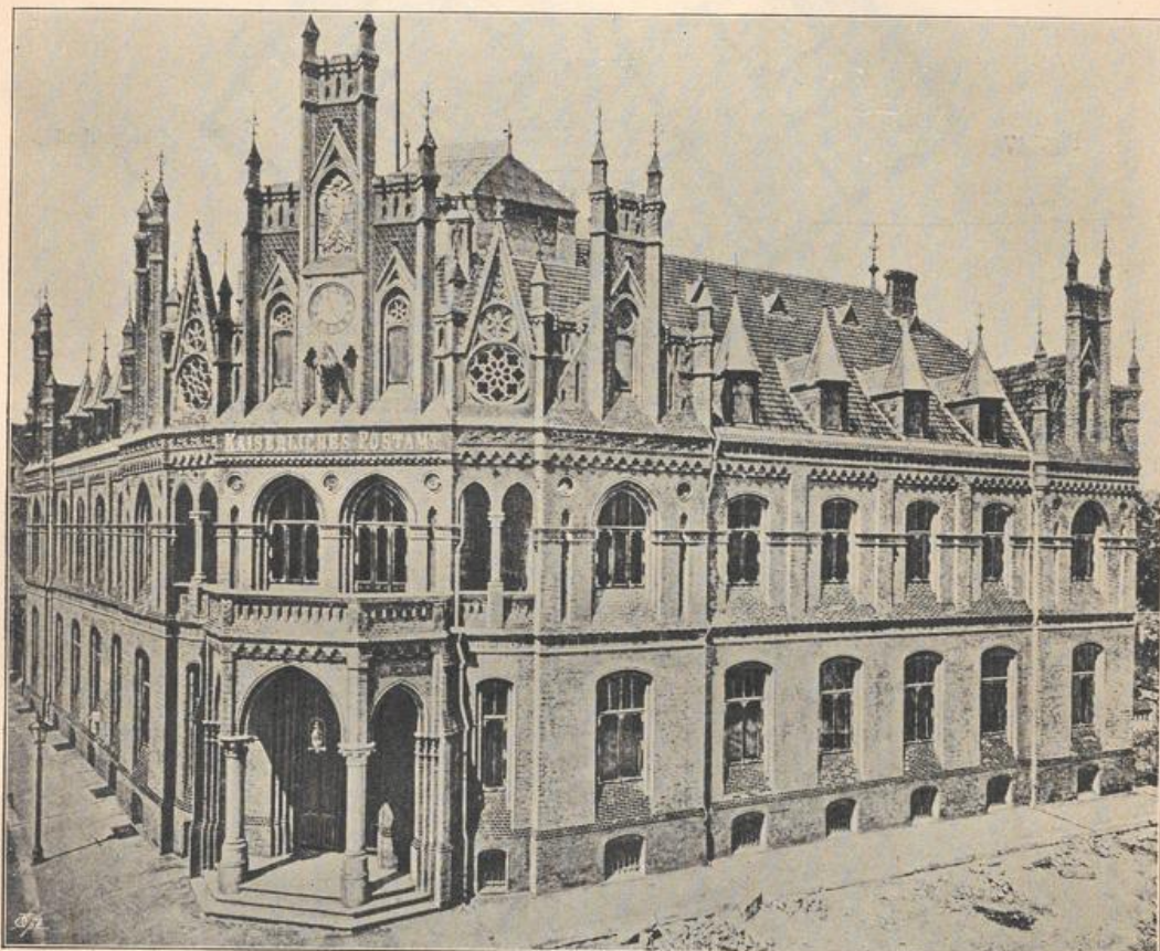
Postgebäude zu Hildesheim.
