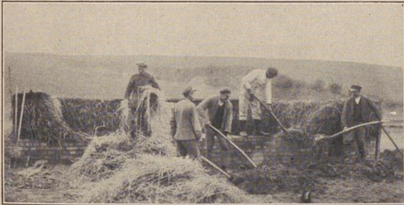
Abb. 1: Die Lehmwellerwand wird aufgebracht. Im Vordergrund der Pfuhl, in dem das Stroh mit dem Lehm gemischt wird.
