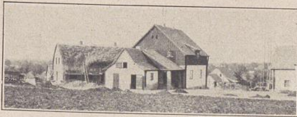
Abb. 7: Lehmgrünlingsbau und Lehmshindelsdach der Lehr- und Versuchsstelle Zepernitz bei Berlin.
