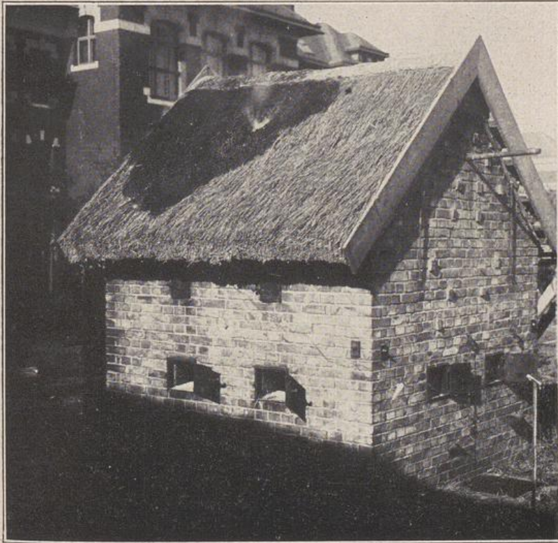
Abb. 4: Trotz völliger Trockenheit und starkem Wind brennt das äußere sperrige Stroh nur langsam schwelend mit kleiner Flamme ab, während die Lehmshindel unbeschädigt bleibt.
