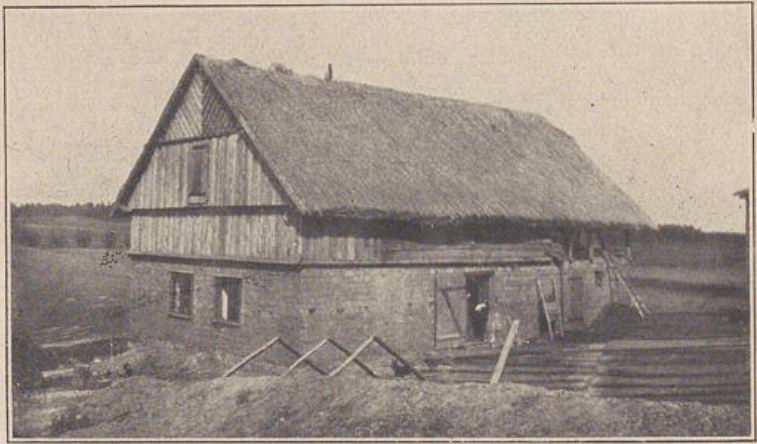
Abb. 8: Ostpreussisches Siedlerhaus, aus Lehmziegeln in Selbsthilfe errichtet. Der Putz ist noch nicht aufgebracht.
