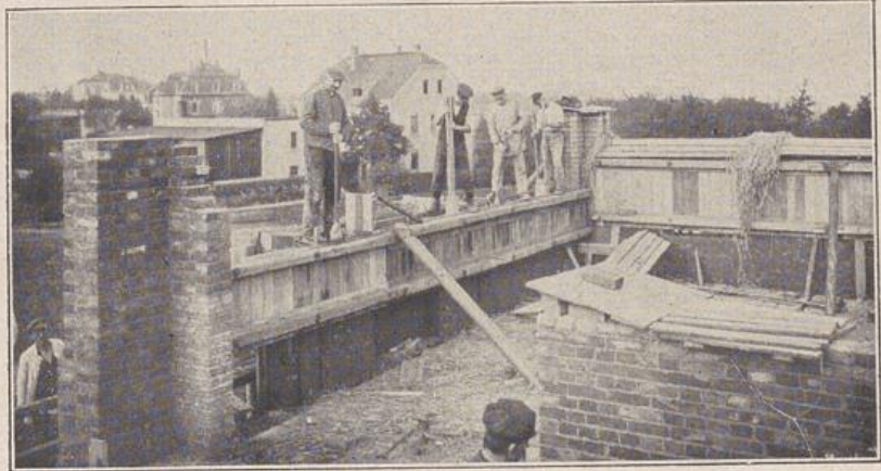
Abb. 3: Das Bild zeigt die gemauerten Schäfte aus Lehmgrünlingen, an welche die Rutschschalung angespannt ist. Ein Teil des Mauerwerks trägt Holzdach als Wetterschutz.
