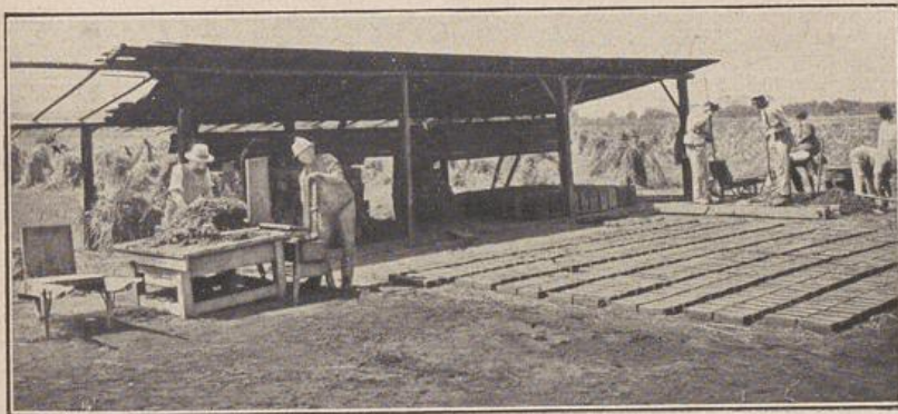
Abb. 1: Herstellung der Lehmziegel (Grünlinge).
