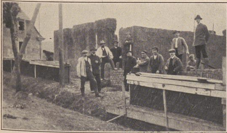
Abb. 2: Die rohe Wand, „der Satz“, vor dem Abstich mit dem Spaten.
