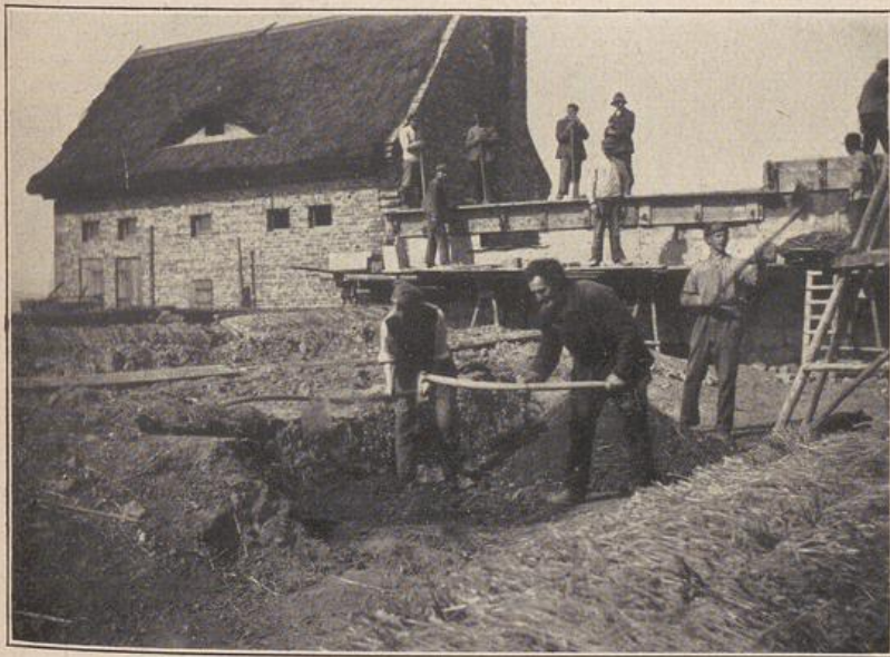
Abb. 2: Lehm-schindeldach, errichtet von der Lehr- und Versuchsstelle für Naturbauweisen in Corau 1921.
