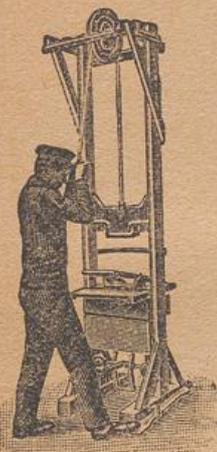
aus unvorbereitetem Lehm (direkt aus der Grube) unter hohem Pressdruck, so daß die Steine sehr widerstandsfähig und so gleich so fest sind, daß sie ohne Unterlagen transportiert und in Stapel gestellt werden können. Beste Referenzen.
