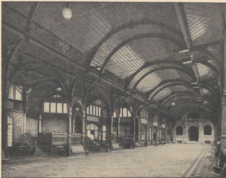
Trinkhalle zu Bad Flinsberg 47) .
