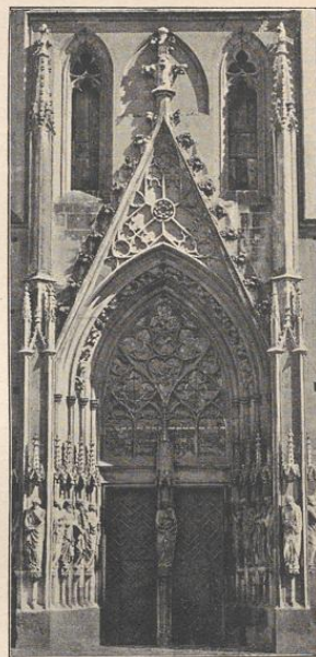
Abbildg. 161. Hauptportal vom Dom zu Münster (Westfalen), nach einer Photographie.
