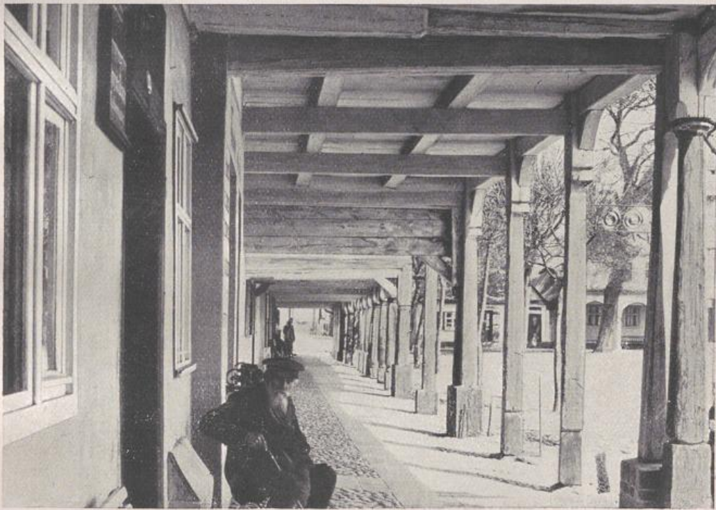
Rakwitz, Laubengang. Aufnahme vom Verfasser.
