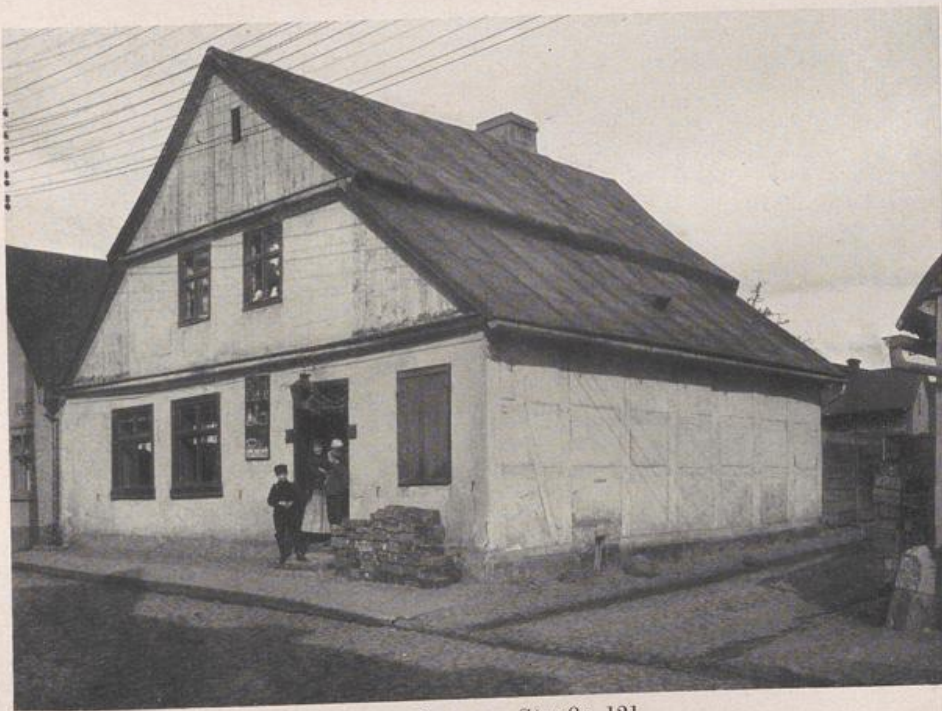
Graetz, Posener Straße 121. Aufnahme Stadtbaumeister Kunze, Meseritz. (Vgl. Grundriß Abb. 60.)
