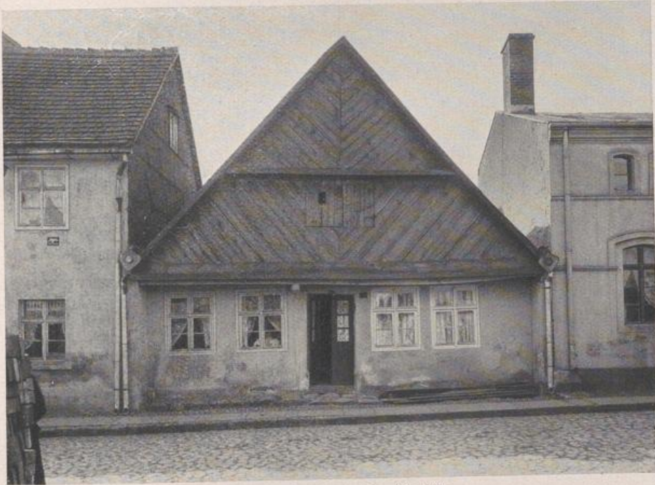
Graetz, Posener Straße 88. Aufnahme Stadtbaumeister Kunze, Meseritz. (Vgl. Grundriß Abb. 59.)
