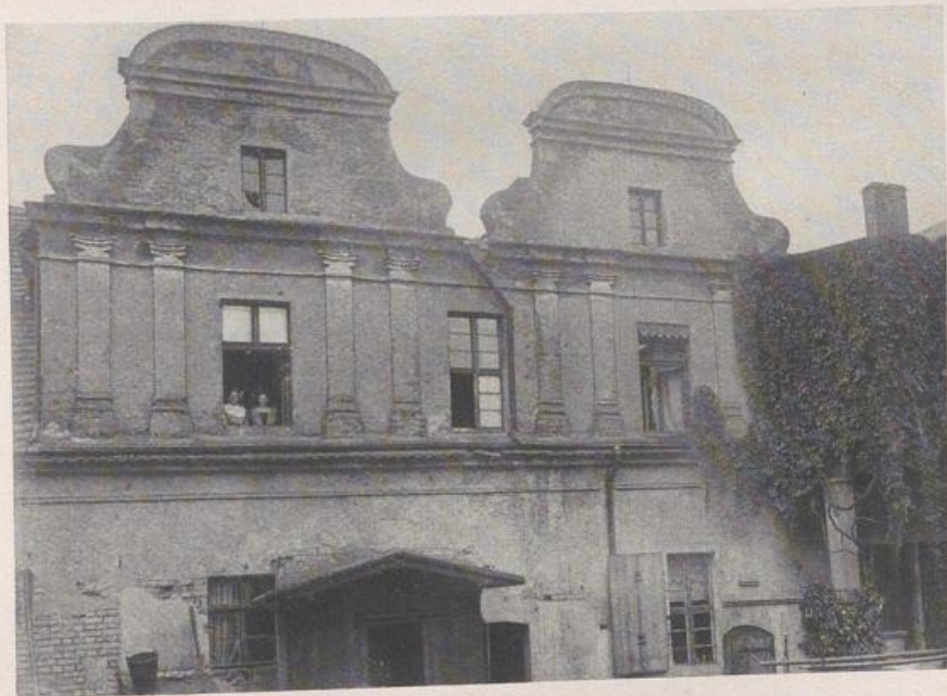
Rawitsch, Alte Giebelhäuser der Vorstadt. Aufnahme Baurat Rambeau †.
