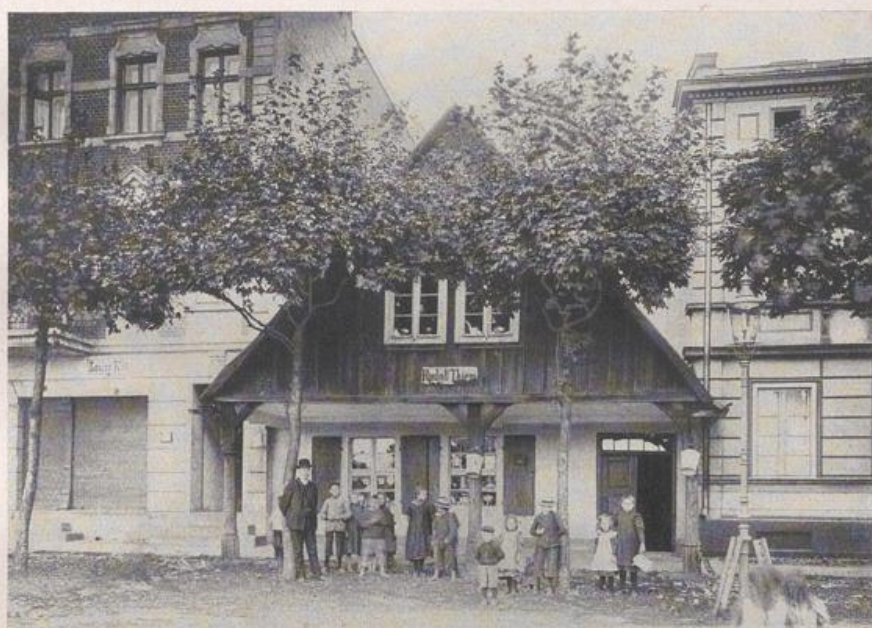
Rakwitz, Laubenhaus in Umgebung neuzeitlicher Häuser. Aufnahme Stadtbaumeister Kunze, Meseritz.
