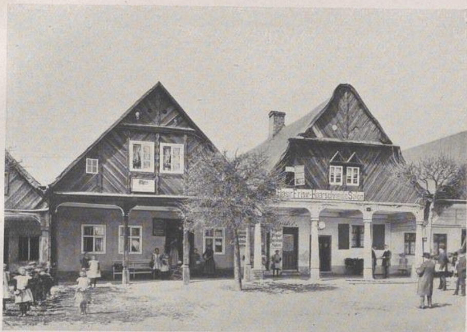
Rakwitz, Markt 124 u. 125. Aufnahme von Regierungsbaumeister Eberhard.
