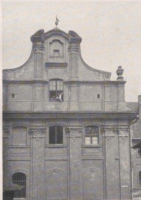
Posen, Giebel Philippinerstraße 4. Aufnahme des Verfassers.
