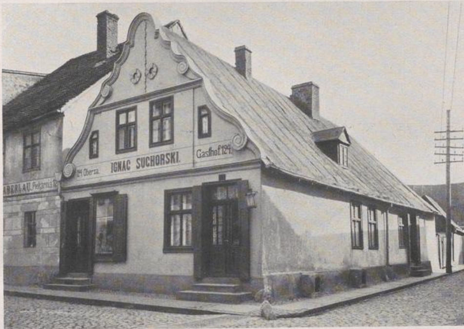
Graetz, Fleischerstraße 124. Aufnahme Stadtbaumeister Kunze, Meseritz. (Vgl. auch Grundriß Abb. 56.)
