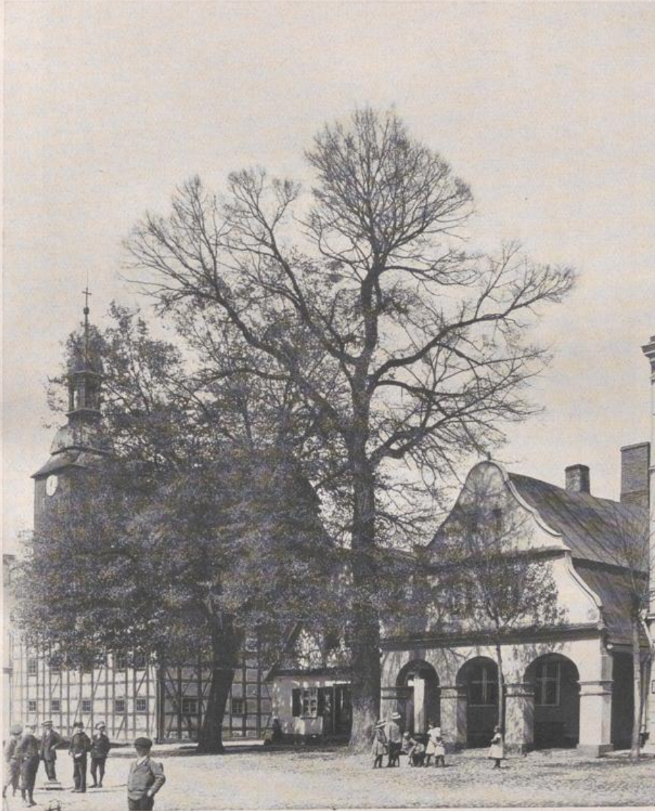
Rakwitz, Pfarrhaus mit massiver Laube. Aufnahme Regierungsbaumeister Eberhard. (Vgl. Abb. 34.)
