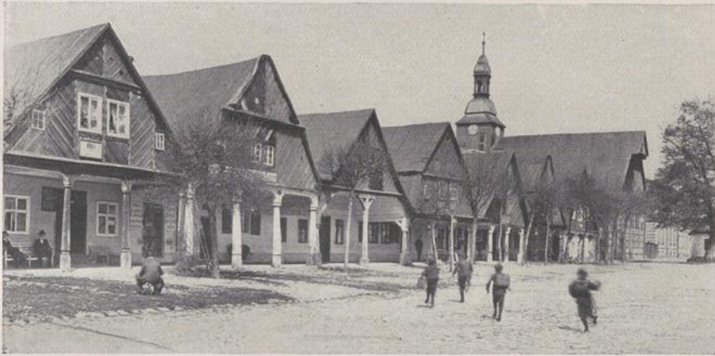
Rakwitz, Laubenhäuser am Markt 124—130. Aufnahme Regierungsbaumeister Eberhard. (Vgl. Abb. 43.)
