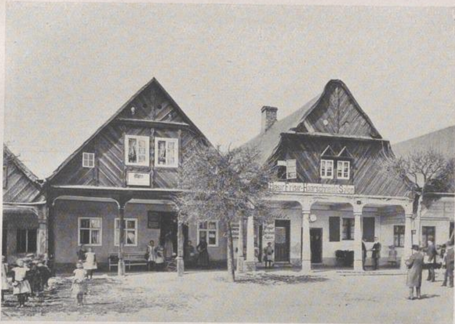
Rakwitz, Markt 124 u. 125. Aufnahme von Regierungsbaumeister Eberhard.
