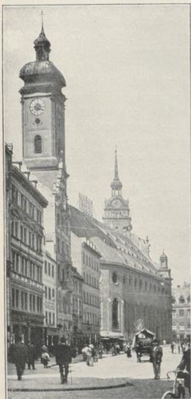
Abb. 9. Heiliggeistkirche. Phot. S. Finsterlin.
