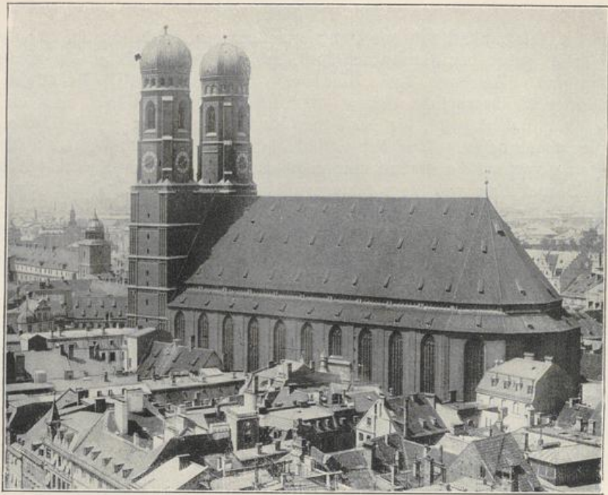
Abb. 12. Frauenkirche. Nordseite. Phot. Würthle & Sohn.
