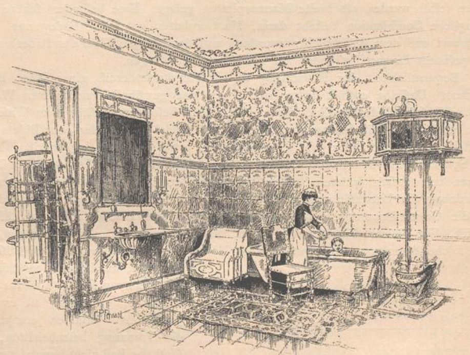
Neuere Anordnung eines Badezimmers.
