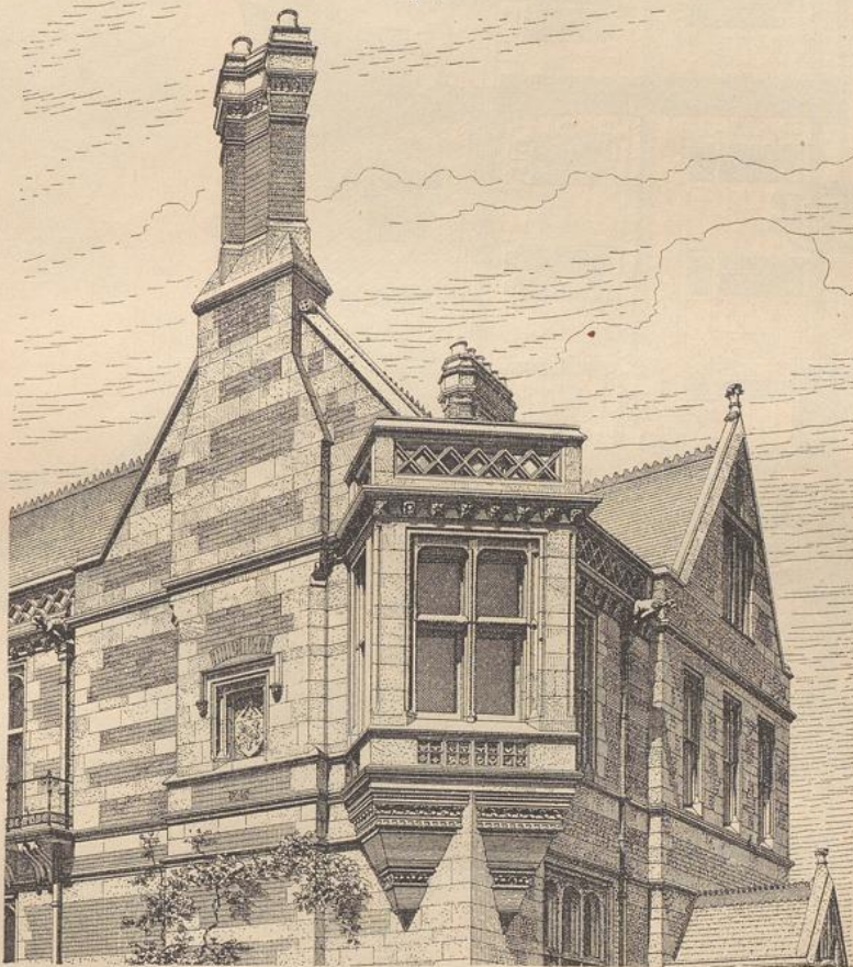
Von einem Wohnhaus zu Cambridge 133) .
