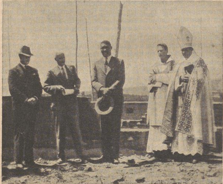
Mgr. Kurz hält die Ansprache bei der Grundsteinlegung. Magistrat von Umtata (Photo: Archiv)
