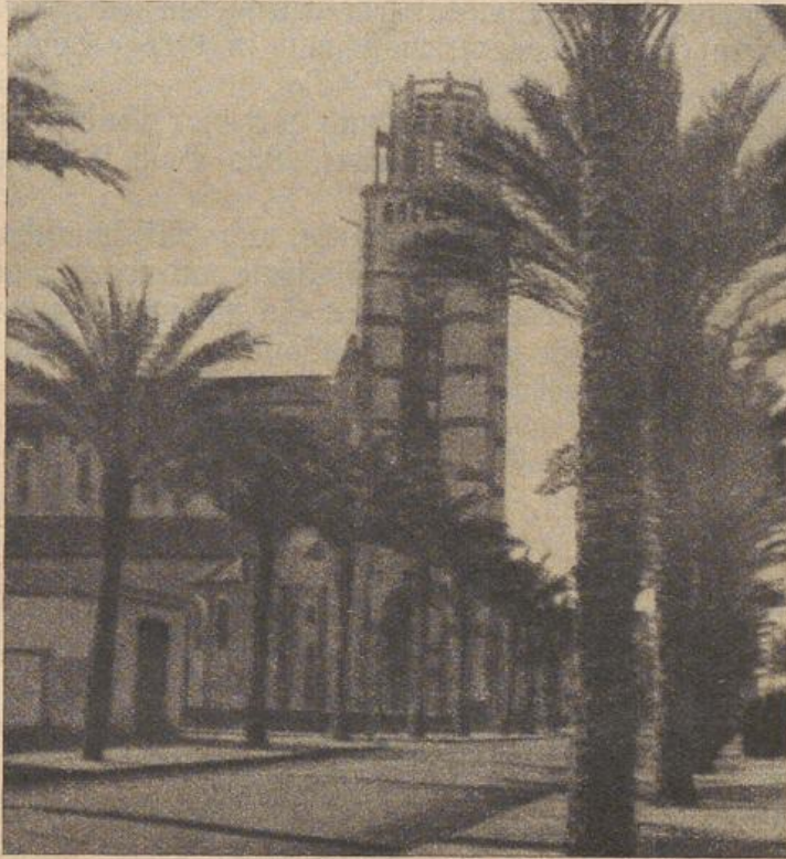
Neue Kathedrale von Port-Said (Photo: Archiv)
