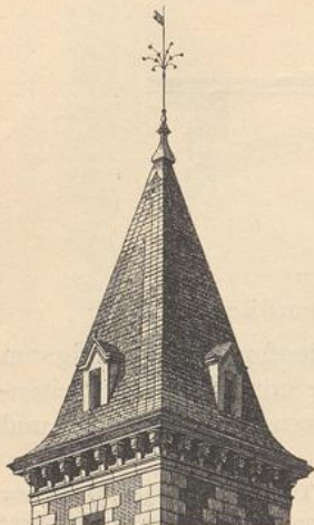
Von einer Villa zu Blanquefort 75) .
