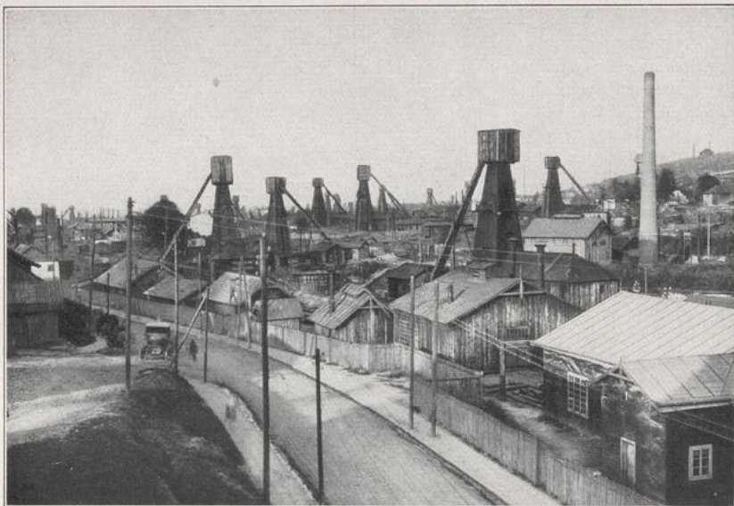
377. Bohrtürme bei Borislaw. Nur aus wenigen „eruptiven“ Schächten schleudern die Gase das Öl selbsttätig heraus. Gewöhnlich wird es bei Flachbohrung gepumpt, sonst gekolbt, wie im Borislauer Revier. Ein Drahtseil läßt den Kolben bis zum Boden des Bohrlochs herab und zieht mit ihm dann die über ihm befindliche Ölsäule empor.
