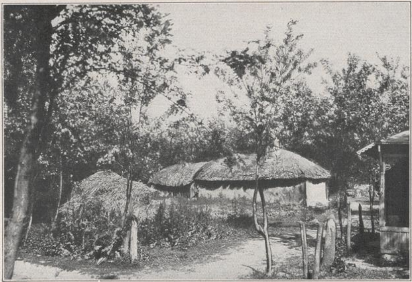
331. Dorf Gradistea in der Walachei. Die Häuser der altrumänischen Landbevölkerung sind dürftige Lehmhütten, weiß gestrichen und mit Maisstroh gedeckt. Die Dörfer liegen meist in kleinen Robinienanpflanzungen. (Phot. Dr. Lücke.)
