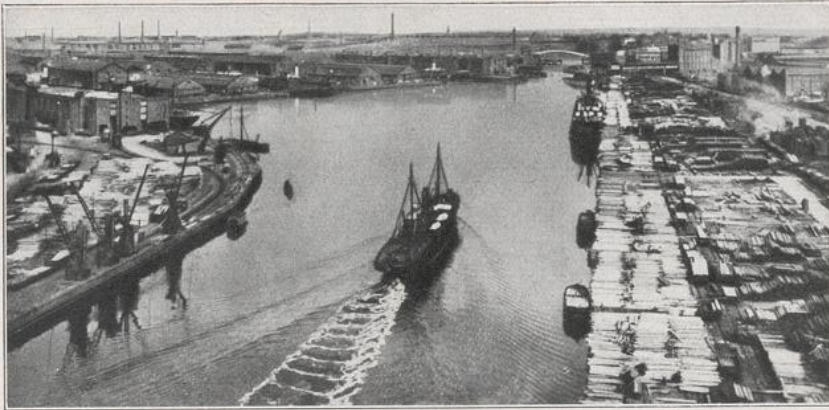
529. Der Manchester-Großschiffahrtskanal. Er verbindet Liverpool mit Manchester. Wenn auch Manchester durch den Kanal den Baumwollhandel Liverpools nicht an sich reißen konnte, so wurden doch die Ufer des Kanals bevorzugtes Gelände für zahlreiche Industriezweige.
