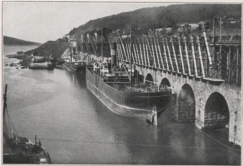
1199. Erzverladebrücken in Narvik. Das schwedische Erz wird in Narvik verladen. Die Erzzüge fahren auf die hohe Brücke, das Erz wird auf den (im Bilde hochgeklappten) Rinnen unmittelbar in die Schiffe geschüttet.
