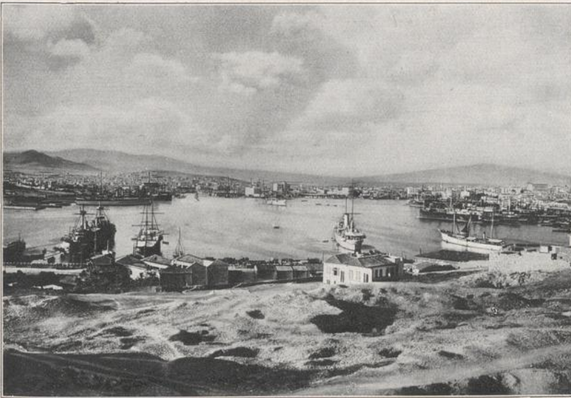
898. Piräus. In den athenischen Küstenhof springt, von Tertiärhügeln umgeben, über die sich die moderne Großstadt Piräus ausgebreitet hat, die Hafnbucht ein, die schon im Altertum Hafenplatz von Athen gewesen ist. Im Hintergrund links Parnes, von dem das Ägaleosgebirge als westliche Randkulisse des athenischen Hofes vorstößt, rechts Pentelikon.
