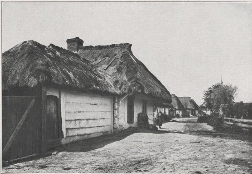
384. Unregelmäßiges Straßendorf in Masowien. Ein besonderes Kennzeichen des dargestellten, hier seltener vorkommenden Haustypus, den man gelegentlich in Masowien, Kujawien und im Posener Lande antrifft, ist der Eingang an der Giebelseite unter vorspringendem Dach oder einer Dachlaube. Man baut fast durchweg aus Holz, verstopft die Fugen mit Moos und streicht das Haus weiß
