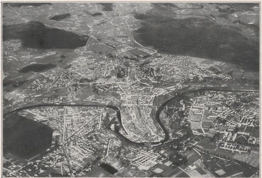
120. Bern (Fliegeraufnahme). Die Hauptstadt der Eidgenossenschaft entstand auf einem Talsporn der 35 m tief eingeschnittenen Aare. In der Längsachse der Flußhalbinsel verläuft die laubengeschmückte Hauptstraße in W-O-Richtung vom Bahnhof zur Nydecker Brücke; rechts davon die 48 m hohe Kornhausbrücke, links der Bundespalast. Auf der Hochebene breiten sich die neueren Viertel aus. Im Hintergrund, gegen W, das von einzelnen bewaldeten Molassebergen unterbrochene, fruchtbare und reich besiedelte Berner Mittelland. (Aufnahme der Ad Astra-Aero A.-G., Zürich.)
