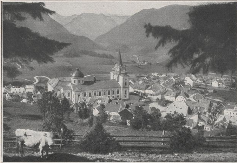
203. Mariazell. Im Quellgebiet der steirischen Salza, in einem beckenförmigen Taltorso zwischen dieser und der Erlauf, liegt der berühmteste Wallfahrtsort der Ostalpen, dem sieben Straßen zustreben. Die stattliche, dreitürmige Wallfahrtskirche mit Schatzkammer, Gnadenkapelle und wunder-tätigem Marienbild wurde 1644 an Stelle der von Ludwig I. von Ungarn gestifteten Kirche erbaut.
