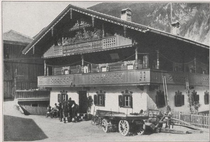
190. Bauernhaus in Mairhofen (Zillertal, Tirol). Typisches bajuwarisches Einheitshaus, giebelseitig zur Straße gestellt, den Eingang auf der Schmalseite, mit flachem Dach, im Untergeschoß gemauert, im Obergeschoß mit Holzwänden, umlaufenden Galerien und reichem Schnitzwerk.
