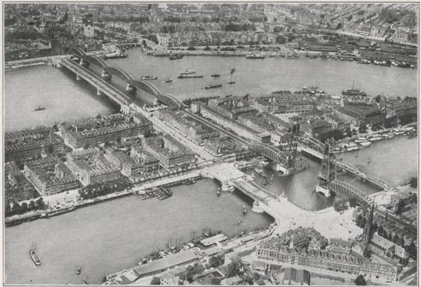
424. Maasbrücken in Rotterdam. Willemsbrücke und Eisenbahnbrücke verbinden Rotterdam über den 300 m breiten Strom (im Mittelgrund) mit dem mehr als 1200 m langen, bebauten Nordereiland und finden jenseits ihre Fortsetzung in den neuen Brücken über den »Königshafen« genannten Maasarm (im Vordergrund).
