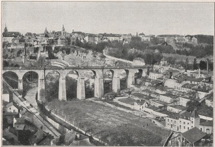
449. Luxemburg. Die ehemalige Festung hat sich heute beträchtlich ausgedehnt über die malerischen, 60 m tiefen Schluchten der Alzette und des Petrusbaches, die einst als Festungsgräben dienten und jetzt mehrfach überbrückt sind.
