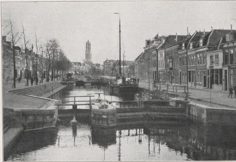
427. Utrecht. Der Flußhafen wird im Hintergrunde von dem 110 m hohen Domturm überragt, der alle Hügel Nederlands außer denen Süd-Limburgs an Höhe übertrifft. Die Stadt durchziehen breite Grachten, deren Ufer mit schönen Patrizierhäusern besetzt sind.
