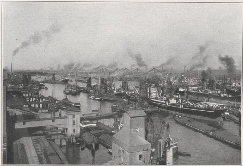
425. Rotterdam, Maashafen. Von den zahlreichen Hafenbecken des Rotterdamer Hafens mit ihren Eisenbahngleisen, Schuppen, festen und schwimmenden Kränen und anderen Umladevorrichtungen wurde der Maashafen (58 ha) an der Stelle des Dorfes Kadendrecht am linken Maasufer angelegt und 1905 vollendet. Er wird an Größe durch den in Bau begriffenen Waalhafen (300 ha) noch wesentlich übertroffen werden. Vgl. Abb. 403a und 403b.
