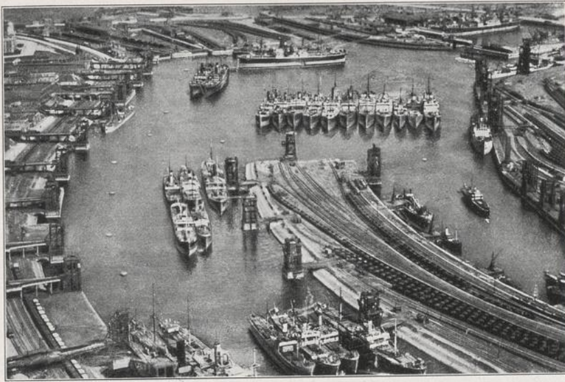
534. Barry Docks, ein Kohlenhafen, etwa 5 km südwestlich von Cardiff. Barry Docks wurde von der Great Western Railway für den Export der Kohle von Wales gebaut. Man erkennt die zahlreichen Türme, in welche die Kohlenwagen gebracht werden, um direkt in die Dampfer gekippt zu werden.
