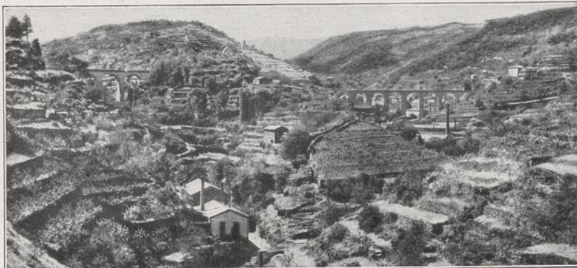
629. Kulturterrassen bei Privas. Zwischen Zentralplateau und Rhôneetal schiebt sich das Zwischengebirge ein (900—1000 m hoch). Die steil eingeschnittenen Täler sind terrassiert. Im Hintergrund des Tälchens (rechts) ein Stück Wölbung des eigentlichen Zentralplateaus.
