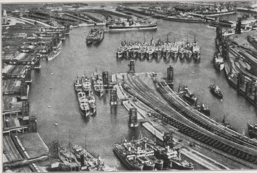
534. Barry Docks, ein Kohlenhafen, etwa 5 km südwestlich von Cardiff. Barry Docks wurde von der Great Western Railway für den Export der Kohle von Wales gebaut. Man erkennt die zahlreichen Türme, in welche die Kohlenwagen gebracht werden, um direkt in die Dampfer gekippt zu werden.
