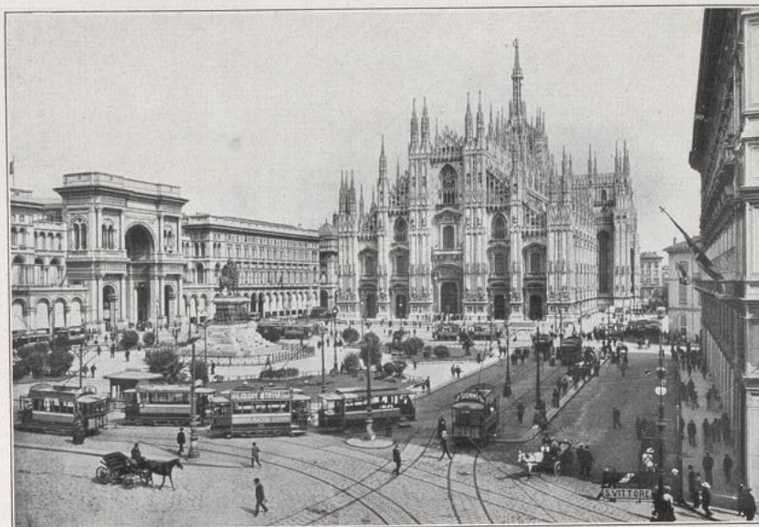
804. Mailand. Piazza del Duomo, das innere Verkehrszentrum. Die hintere Hälfte des Bildes wird von dem aus weißem Marmor in italienischer Gotik erbauten gewaltigen Dom eingenommen. Davor die Reiterstatue Viktor Emanuels II. Links der Eingang zur Galleria Vittorio Emanuele, einer der großartigsten Kaufhallen Europas, die die Stellung des städtischen Zentrums unterstreicht.
