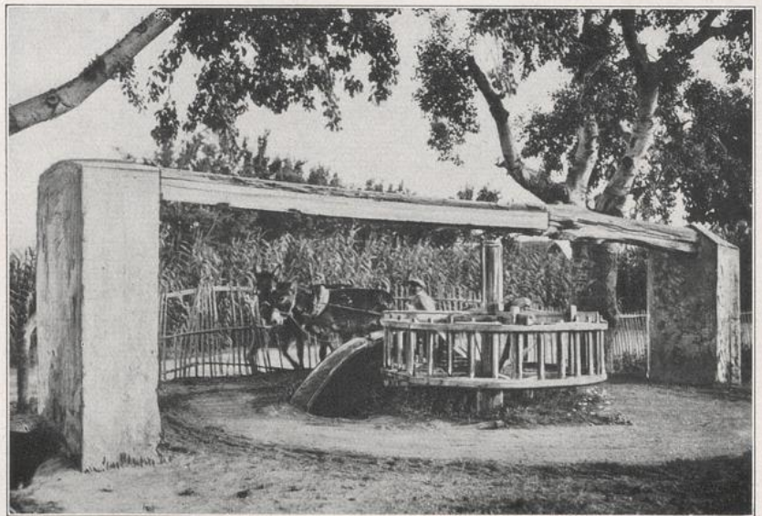
747. Künstliche Bewässerung bei Orihuela. Von Natur aus Wüstensteppe, bedarf das Land künstlicher Bewässerung, und die Oasen, die sich in Flußwasser- und Quellwasservegas teilen (vgl. Abb. 715), sind zugleich die Gebiete dichtester Bevölkerung. Das Wasser wird mit Hilfe eines Schöpfapparates (Noria) aus dem Boden gehoben und auf die Felder verteilt.
