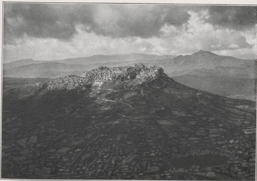
831. Calascibeta. Typische Akropolisiedlung, Bergstadt, an der Grenze von Mittel- und Ostsizilien. Auf engem Raum drängen sich die Häuser, die sich um die Kirchen in beherrschender Lage scharen. Der ganze Wirtschaftsraum liegt tiefer als die 878 m hoch gelegene Stadt. Im Hintergrunde erstrecken sich Teile des nordsizilianischen Berglandes. (Südlich von Calascibeta liegt die gleichartige Siedlung Castrogiovanni, das alte Enna, 997 m hoch.) (Phot. Maull.)
