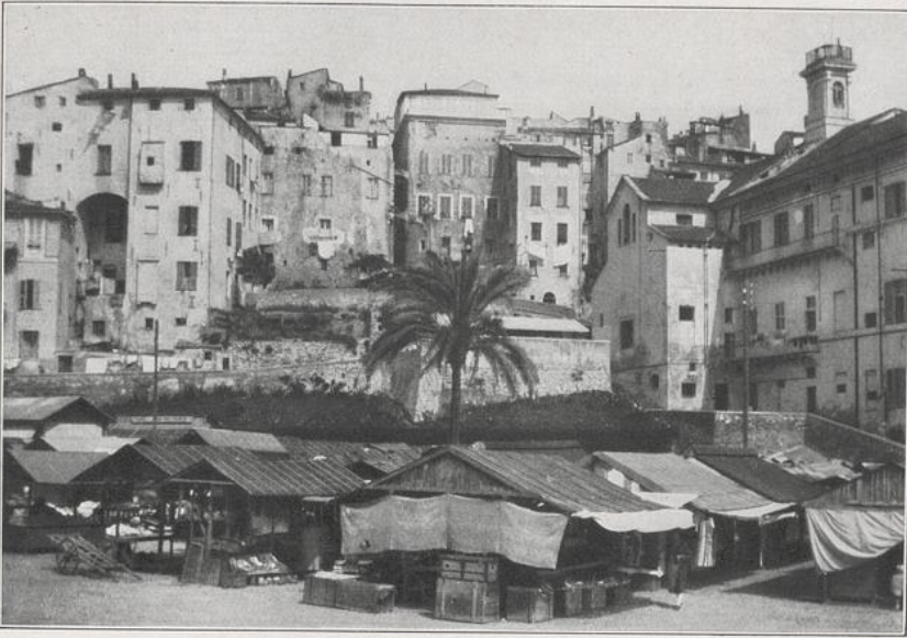
814. San Remo, Altstadt. Marktplatz unter der durch Hochhäuser charakterisierten, in steilen Treppengassen aufsteigenden Altstadt (Civitavecchia). Zwischen den Häusern überspannen Strebebogen die Gassen. Die Civitavecchia ist der Typus für die alten städtischen Kerne an der Riviera. In der Tiefe davor lagert die neue Geschäftsstadt, die zum Kurort San Remo hinleitet. (Phot. Maull.)
