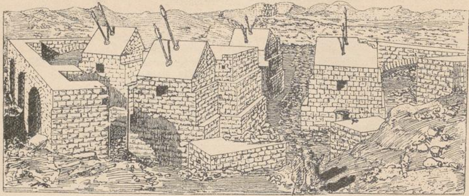
Blick auf die Fundamente eines Eckpfeilers 286 ).
