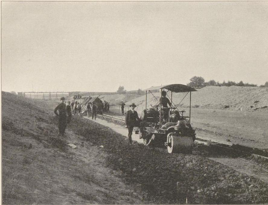
Motorwalze im Betrieb bei Herstellung der Tondichtung.
