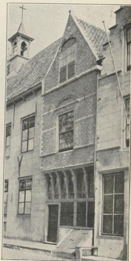
Abb. 274. Giebelhaus mit Holzunterbau in Veere.
