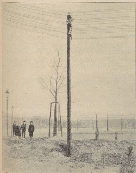
Abb. 2. Oberleitung mit Puppenspulen ausgerüstet.
